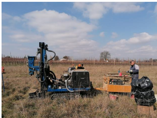
Figura 14 – sondaggio S5-pz2, piazzamento sonda
