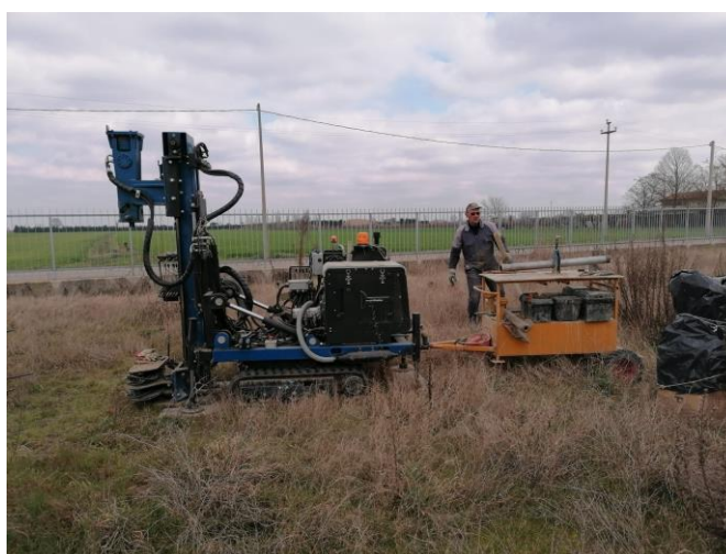
Figura 7 – sondaggio S2, piazzamento sonda
